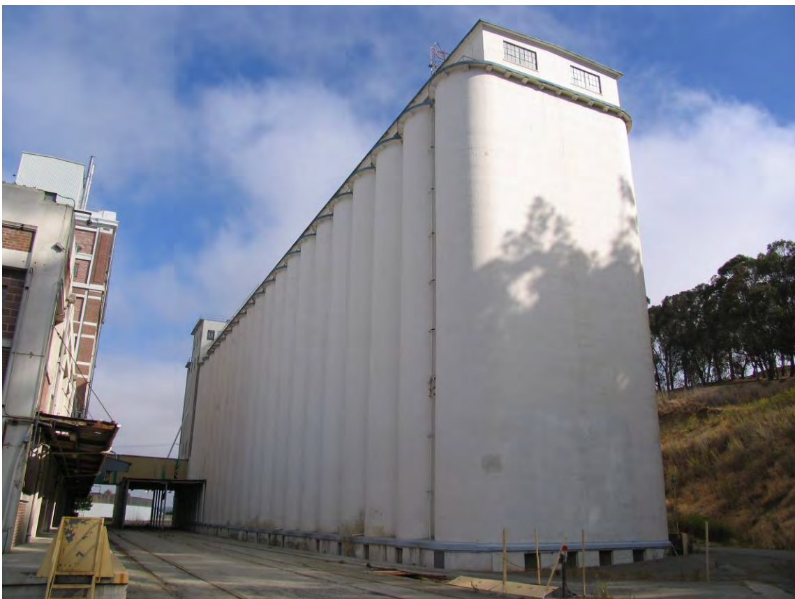
Grain silos. Carey & Co., Inc., 2007.
